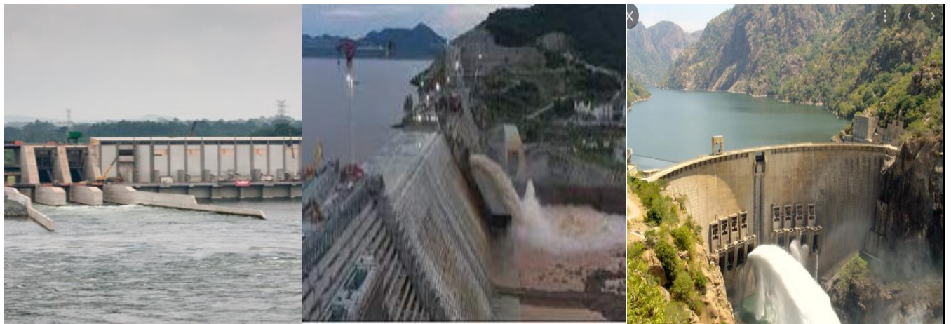
ሀ) የቡጃጋሊ ግድብ (ዩጋንዳ) ለ) የኢትዮጵያ ህዳሴ ግድብ ሐ) የካሪባ ግድብ (ዚምባብዌ)
